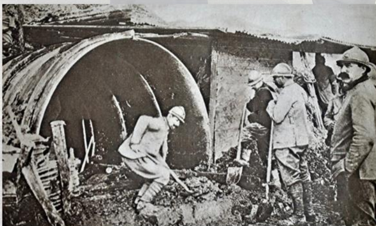
CONSTRUCTION D'UN ABRI BLINDÉ
