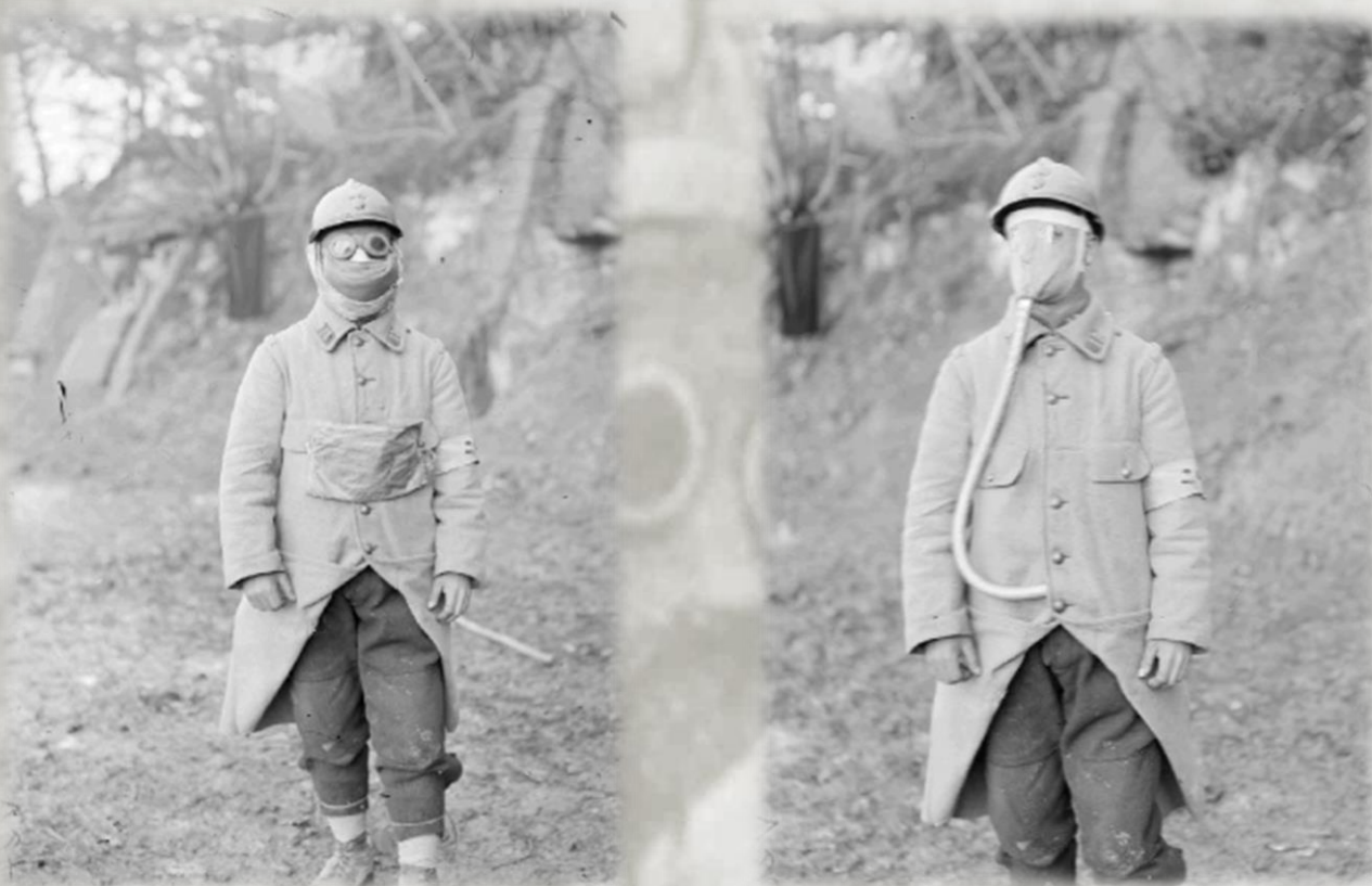
La Renarde (Marne), masque P 2 aux trois compresses contre les gaz. 30 novembre 1915. La Renarde (Marne), masque à tuyau contre les gaz asphyxiants.
